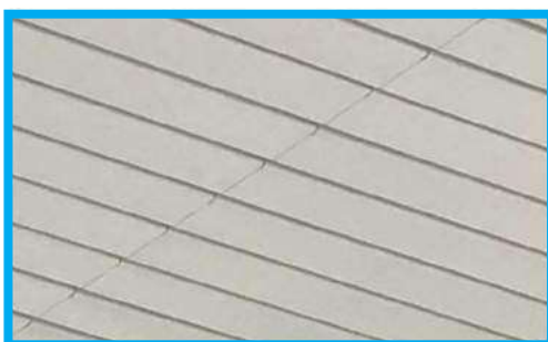
GIUNZIONE DOGHE SORMONTO SOVRAPPOSIZIONE
