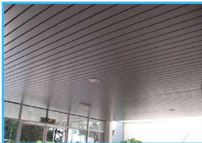
Tipo 43 STRONG ALU Portante di supporto alluminio preverniciato nero su 2 facce. Spessore mm.10/10 Lunghezza mm.4000 - Fuga aperta passante mm.20
