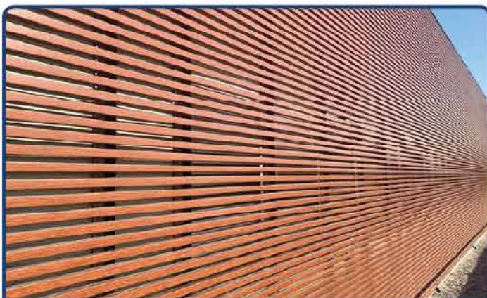
DOGHE Doghe bordo arrotondato e bordo squadrato, aperte passanti, chiuse con scuretto o accostate. Ispezionabili ed antigiangiamento per interno.
