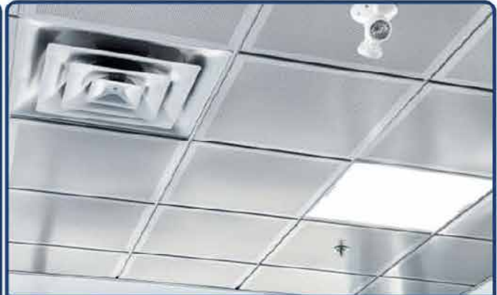
PLAFONI Plafoni mm.600x600 struttura nascosta CLIP-IN e BOXER appoggio su T24-15. Alluminio e acciaio preverniciato.
